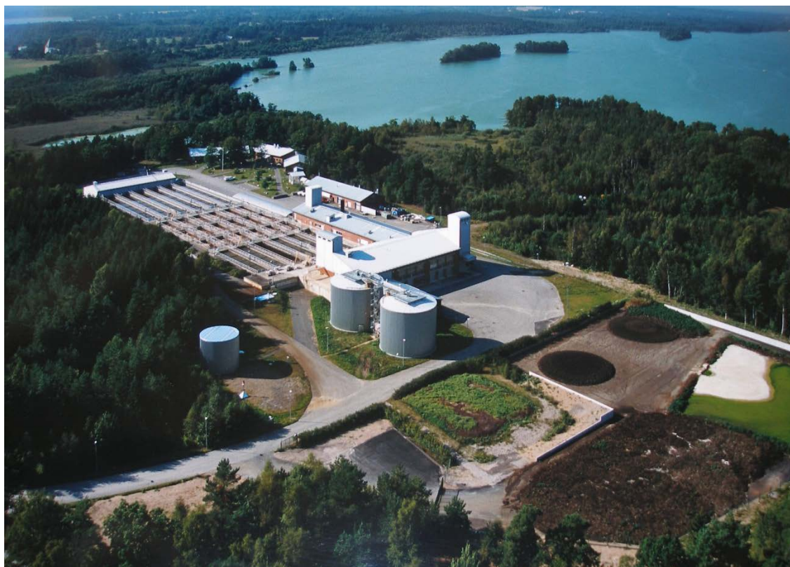
Sundets reningsverk, Växjö (Foto: Växjö kommun)
