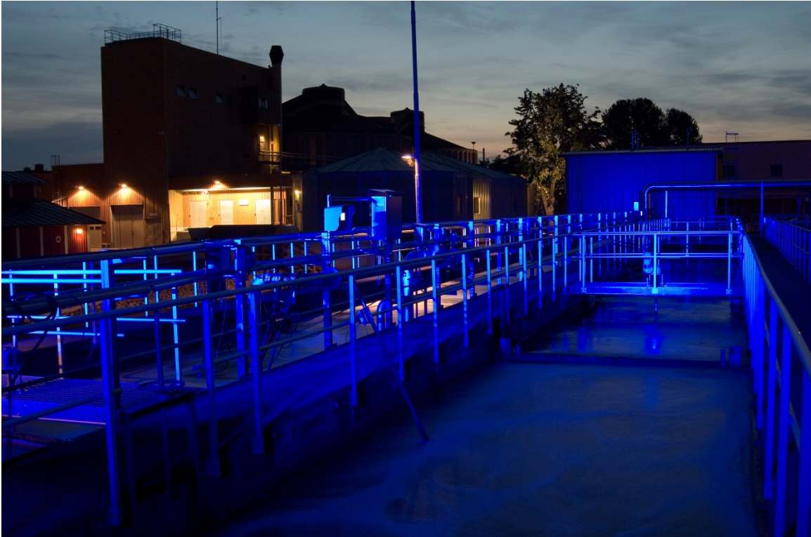
Kungsängens reningsverk, Västerås (Foto: Mälarenergi)
